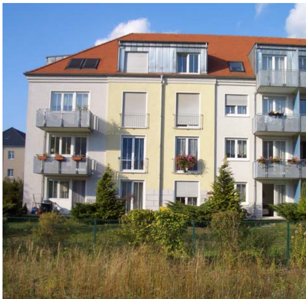
- vor der Balkonmontage
