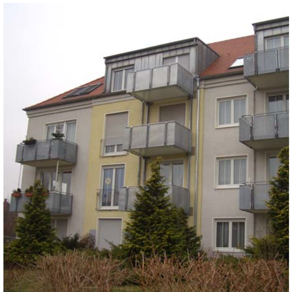
- nach der Balkonmontage
