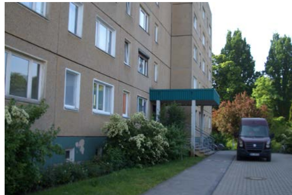
vor der Erneuerung
