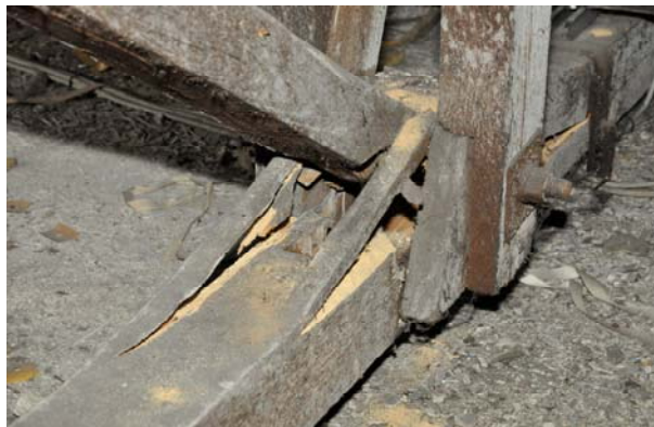
gebrochener Dachstuhl
