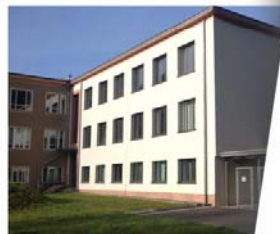
Bild 2: saniertes Kopfbau G013 - Rückseite mit Antriebshaus Landbau Ost
