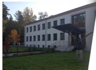
Bild 1: saniertes Kopfbau G013 - Hauptparking Nordseite
