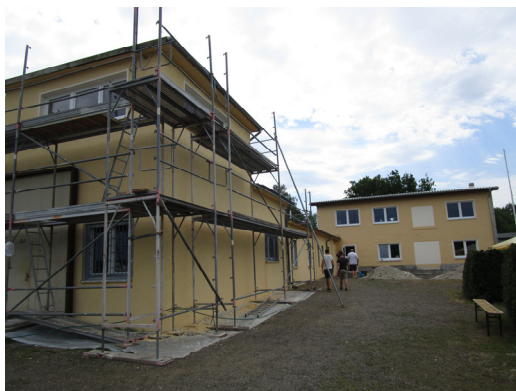
während der Sanierung
