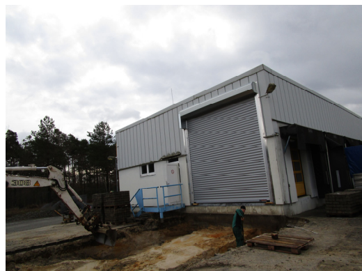
Einbau Tor und Anbau Rampe am Nordgiebel
