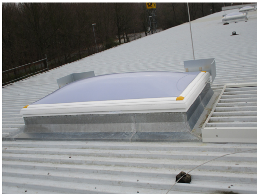
Austausch der vorh. RWA-Anlagen
