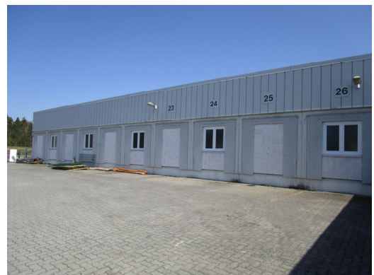
Rückbau der Sektionaltore, Schließen der Öffnungen und Einbau neuer Fenster
