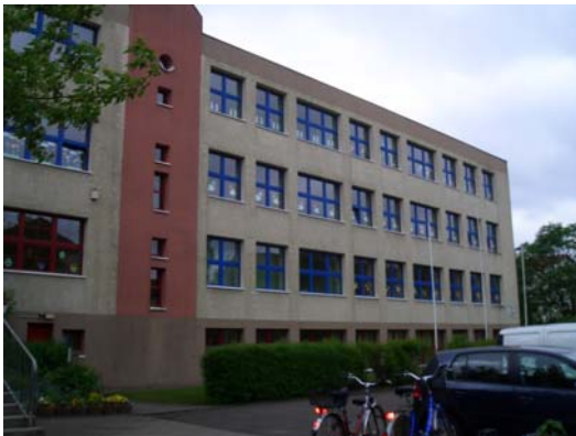
Fassade vor der Sanierung
