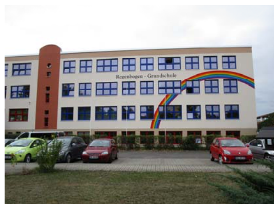
Fassade nach der Sanierung
